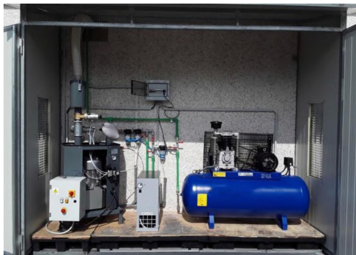
Отдельный блок всасывания на производстве Separated side channel blower unit in technical environment
